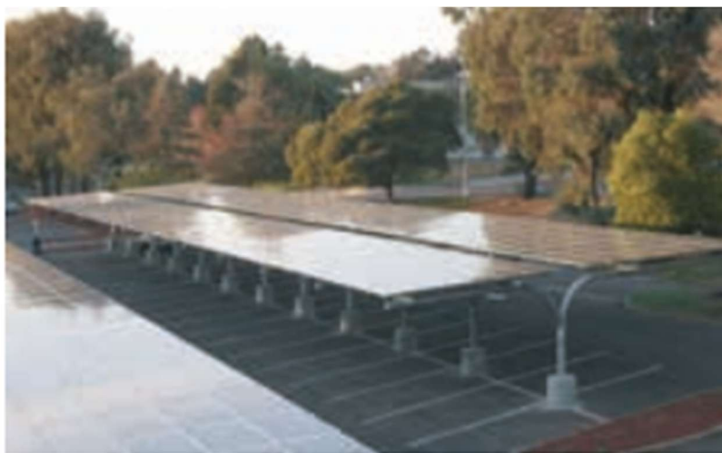
Zatienenie parkoviska fotovoltaiickými panelmi
